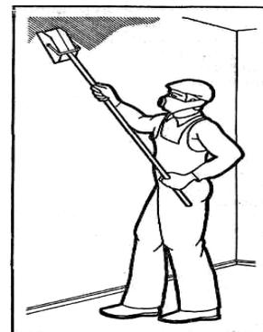
3. *Расшивка трещин и частичная подмазка.* Расшивка трещин производится специальным ножом. При этом плоскость ножа должна быть под углом 45° ...60° к обрабатываемой поверхности (вправо при одном движении и влево при другом). Подмазка трещин и выравнивание шпатлевки производится взаимно перпендикулярными движениями узкого шпателя поперек и вдоль трещин. Работа ведется со столиков – подмостей, которые переставляют по ходу работы.
