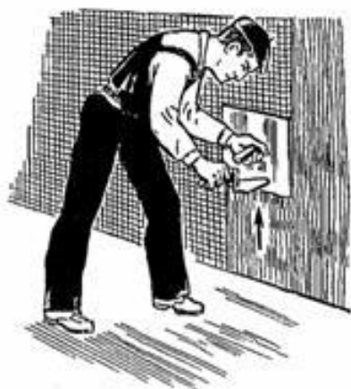
Рис. 90. Нанесение штукатурного раствора на стальную сетку
